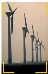
Les aérogénérateurs (ou éoliennes) convertissent la **force du vent** en électricité. Ils sont constitués d'un tour sur lequel tourne une **hélice** composée de 2 ou 3 pales (de diamètre allant de 40 à 100 mètres pour les plus grandes éoliennes). Celles-ci captent l'énergie du vent pour faire tourner une génératrice qui produit du courant électrique.
